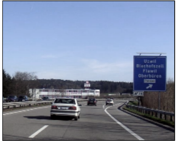
Daniel Duarte arbeitete am Bau der Autobahn A1 bei Flawil mit.
